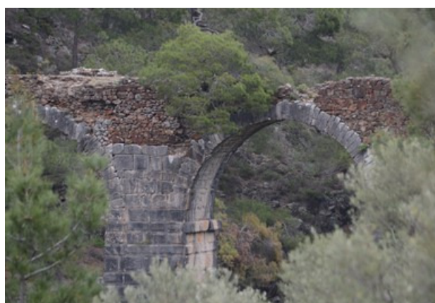
Den gamle akvadukt
