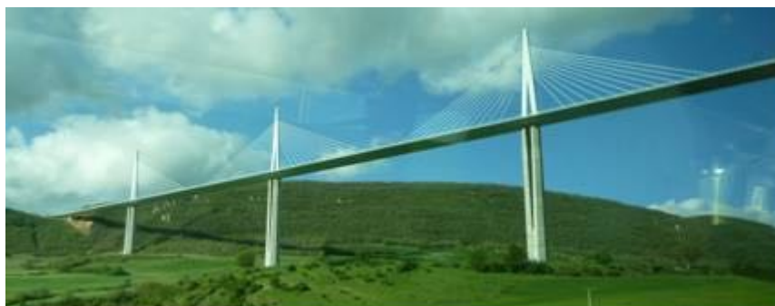
Viaduc de Millau
