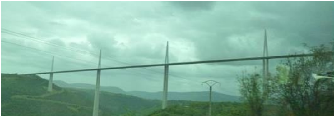
Viaduc de Millau
