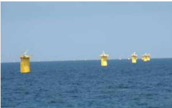
Fundamenter til vindmølleparken
