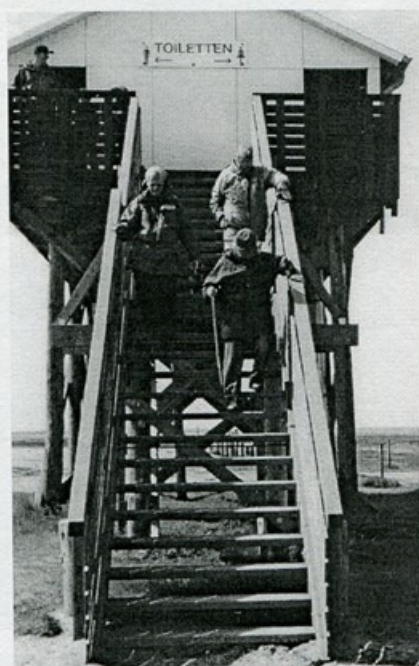
Strandstole og et toilethus bygget på pæle
